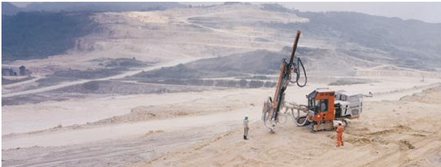
TAMROCK ÄR ENGAGERAT I OMFATTANDE INFRASTRUKTURPROJEKT ÖVER HELA VÄRLDEN.
